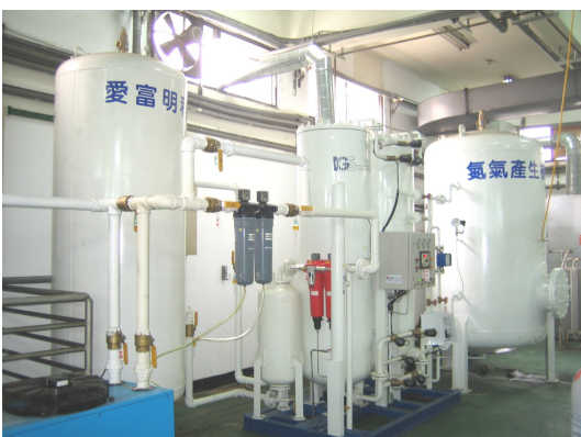
圖 17. 兩台雷射切割機量產中之氦氣機系統 (用戶) 氦氣機系統 (氦氣純度達 99.995%)
